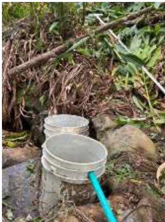
Obra de Captación y control de caudal
