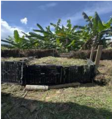
Fotografía 7. Vista general del área de compostaje, evidenciando organización del material y ausencia de disposición en zonas de protección hídrica.
