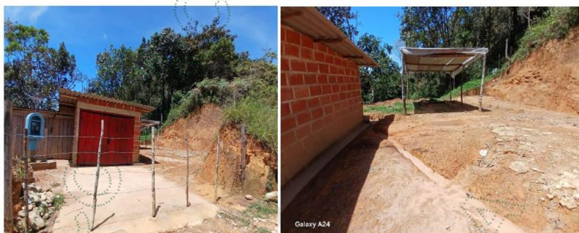
Imagen 1 y 2 estado actual donde se realizó el movimiento de tierra
