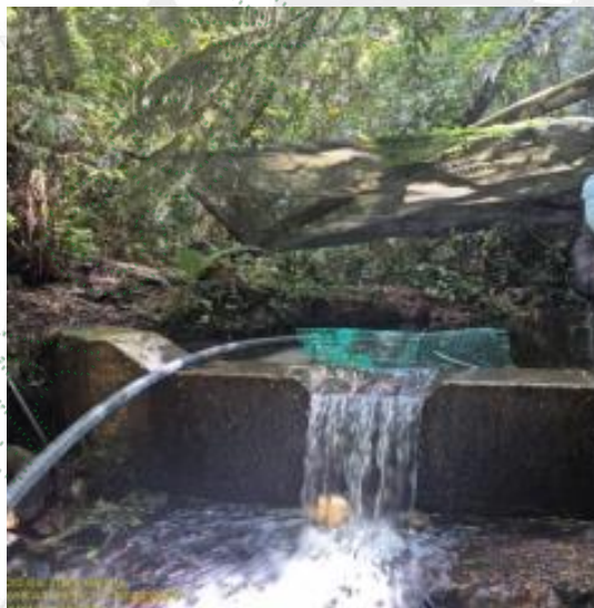
Imagen 1: Caudal ecológico discurriendo aguas debajo de la fuente, después de la estructura de captación – Extraída del informe técnico con radicado IT-02104-2026 , del 16 de abril de 2026
