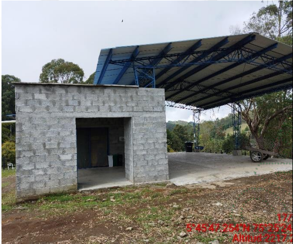
Área de Bodega
