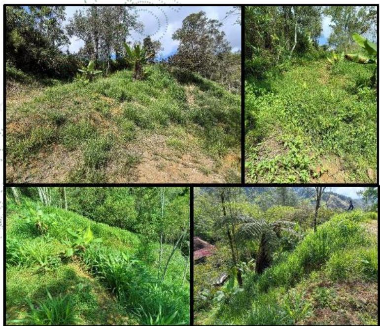
Imagen 3. Cornare. 2026. Revegetalización pasiva y activa sobre el talud o ladera de la explanación 2.
