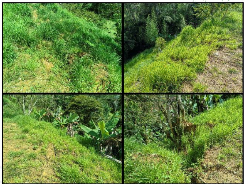
Imagen 2. Cornare. 2026. Revegetalización pasiva y activa sobre el talud o ladera de la explanación 1.
