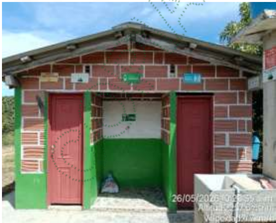
Bodegas – batería sanitaria
