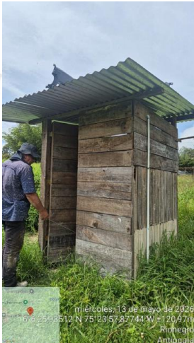
Caseta del sanitario provisional
