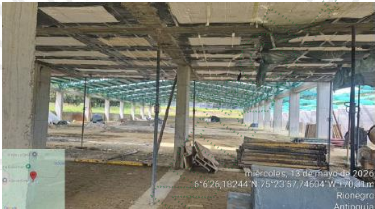
Estado de avance de las obras civiles del proyecto (estructura de caballerizas, picadero y escaleras de acceso)
