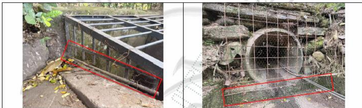
Imagen 1. Instalación de a maya hexagonal.
