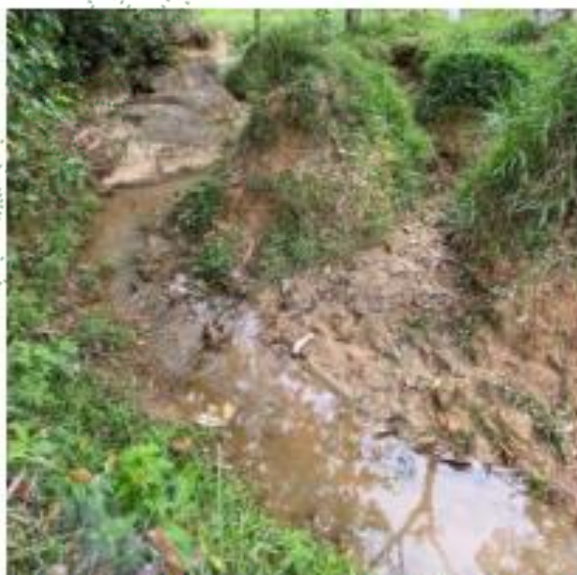
Imagen 4. Fuente hídrica sin protección – Drenaje Sencillo.
