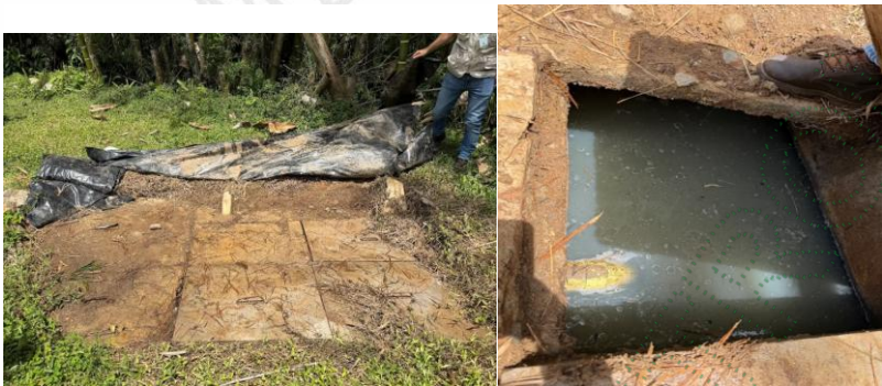
Imagen 6 y 7 Sistema séptico #2 Hotel El Trocadero, vereda El Arenal San Rafael. Cornare 2026.
