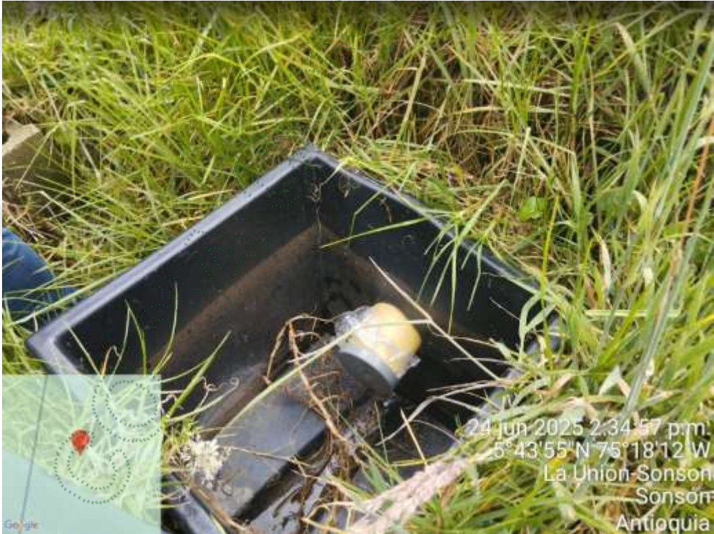
Clausura del vertimiento de ARD en caja de inspección después del STARD
