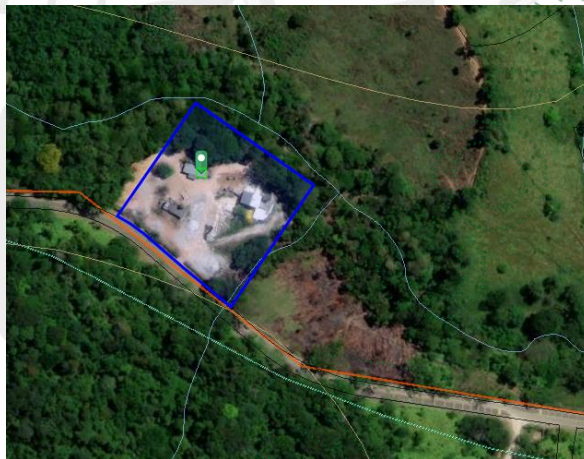
Figura 1. Predio donde se ubica la empresa CALCAREOS Y ENMIENDA S.A.S.
