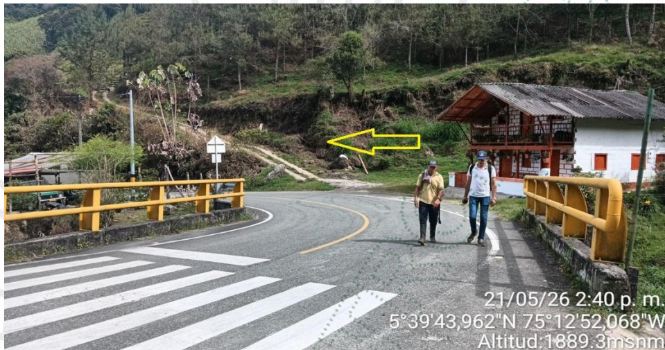
Ingreso al predio San Miguel. Puente San Miguel vía Sonsón – Nariño
