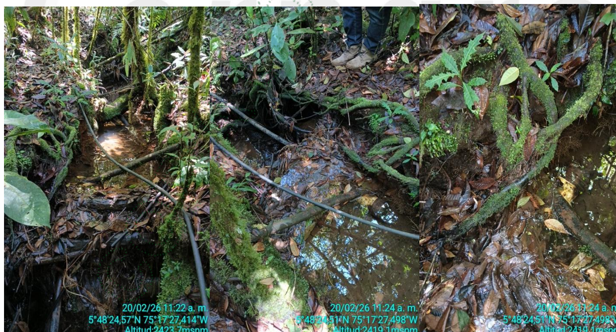
Punto de captación fuente La Cabaña
