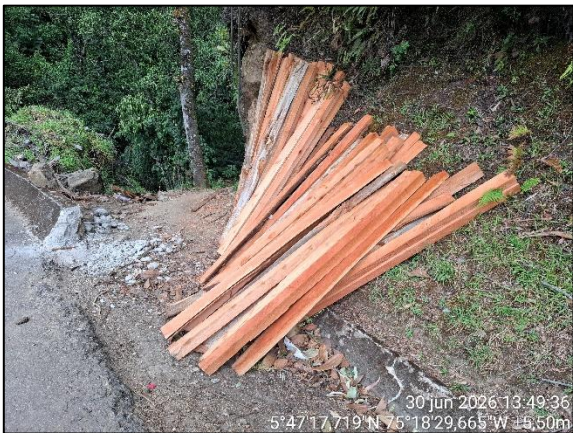
Acopio de madera
