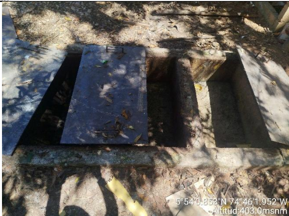
Figuras 2 y 3. Estado actual sistema de tratamiento de aguas residuales domésticas – Unidad preliminar trampa de grasas
