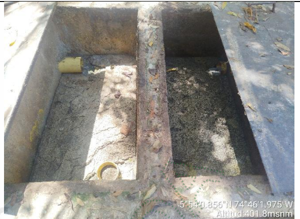
Figuras 2 y 3. Estado actual sistema de tratamiento de aguas residuales domésticas – Unidad preliminar trampa de grasas
