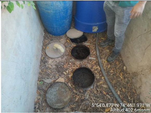
Figura 4. Estado actual sistema de tratamiento de aguas residuales domésticas – Tanque séptico y FAFA
