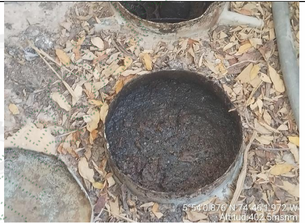
Figura 4. Estado actual sistema de tratamiento de aguas residuales domésticas – Tanque séptico y FAFA
