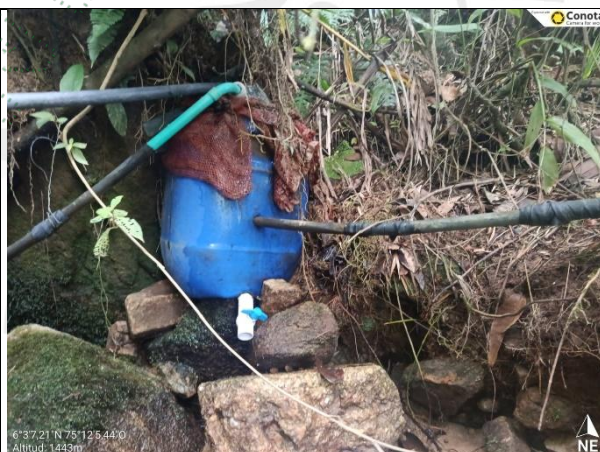
Imagen 3. Tanque sedimentador. Cornare 2026
