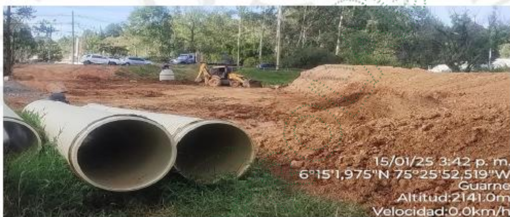
Ilustración 1 se observa maquinaria, persona y materiales ejecutando obra civil.
