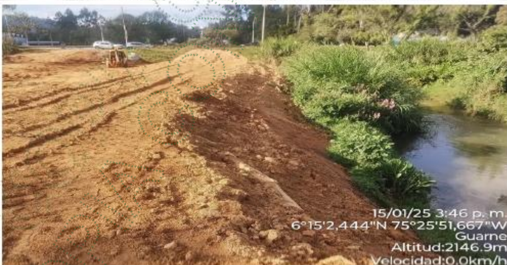
Ilustración 2 obra civil en la margen de la Quebrada La Mosca.
