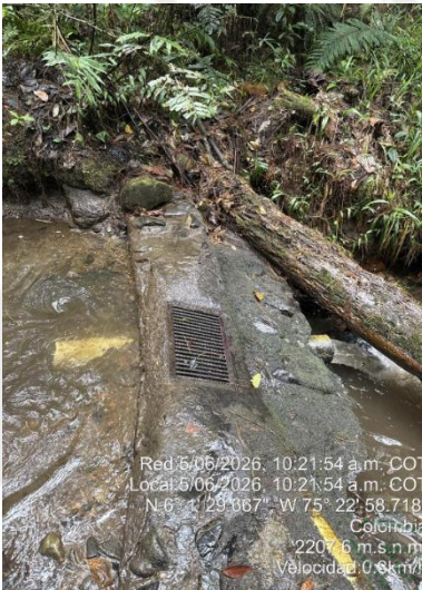
Obra de captación (toma de rejilla)
