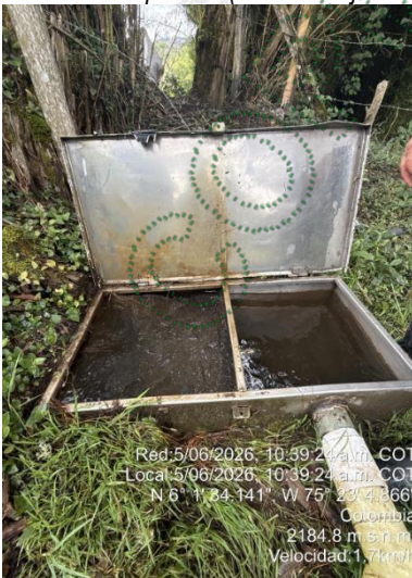
Obra de control de caudal
