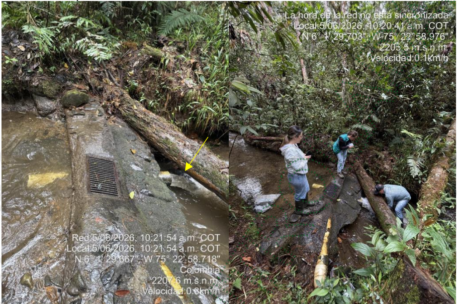
Obra tipo rejilla de fondo
