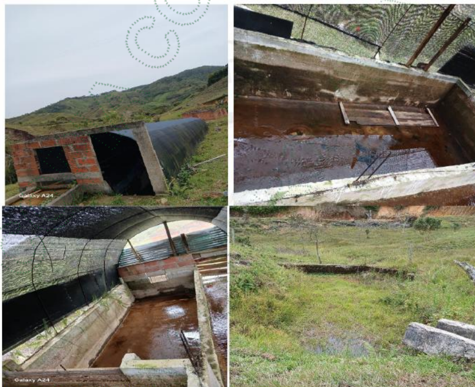
Imagen 1,2,3 y 4 estado actual de los estanques
