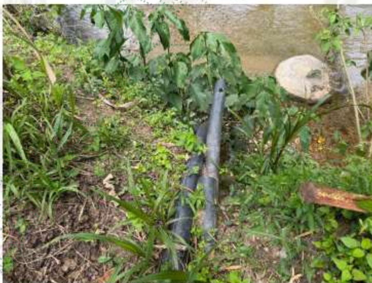
Imagen 4. Mangueras dispuestas sobre el cauce del Río Concepción.
