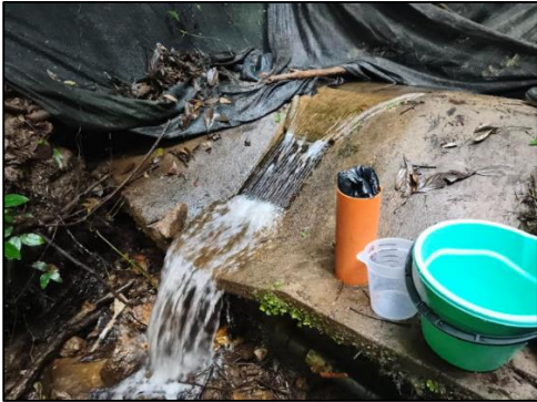
Figura 8. Punto para la captación de la fuente “El Fontanar”
