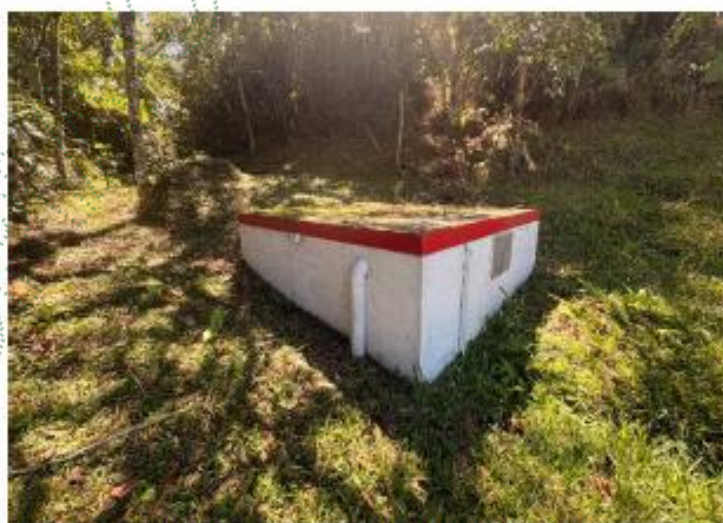
Imagen 1 . Tanque de Almacenamiento de la J.A.C Playa Rica.
