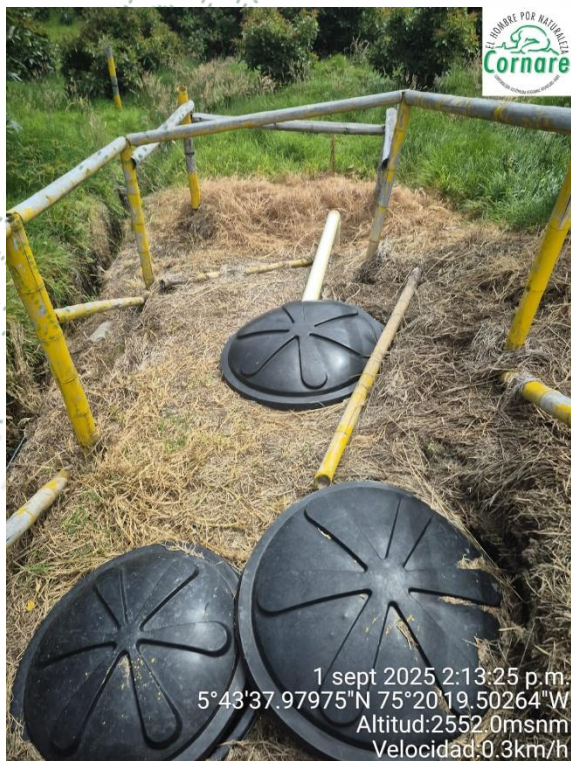
Imagen 12. Pozo séptico de las zonas de descanso
