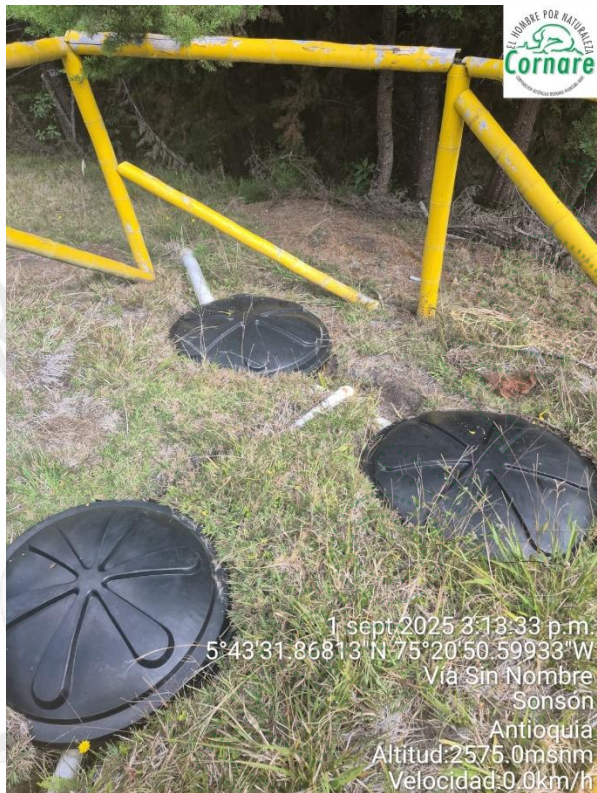
Imagen 12. Pozo séptico de las zonas de descanso
