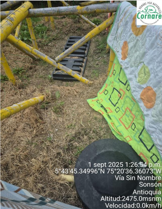
Imagen 11. Pozo séptico vivienda principal.
