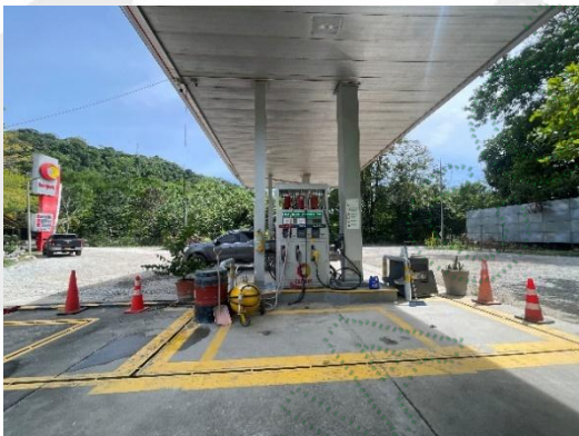
Imagen 1. Cárcamo perimetral de la EDS Río Claro
