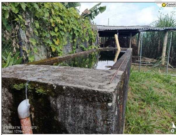
Imagen 4. Tanque desarenador. Cornare 2026
