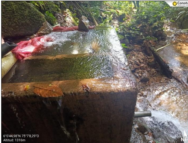
Imagen 2. Tanque sedimentador. Cornare 2026
