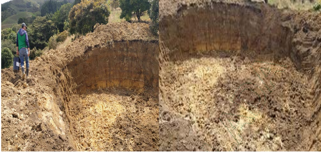
FOTO: Excavación de 12 m de diámetro aproximadamente y al momento de la visita 3 m. de profundidad, para un aljibe en predio El Moreno con PK PK756200100000040007.
