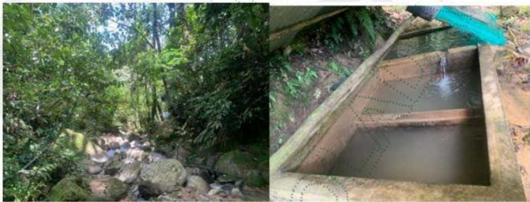
Figura 2. Quebrada La Mina y tanque desarenador
