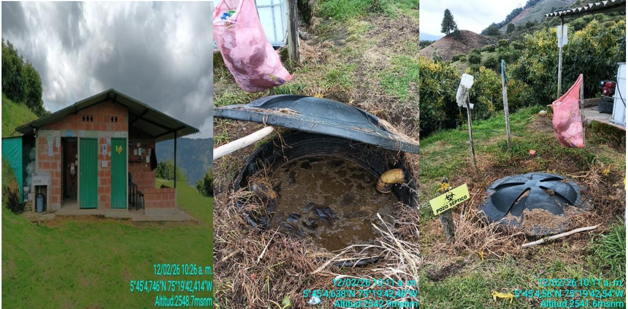
STARD 1. Zona de descanso y bodega
