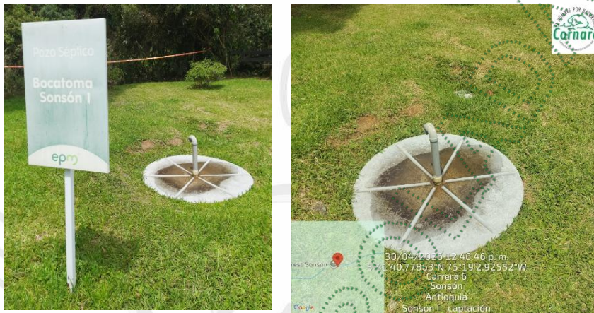
Fotografía 1. STARD Bocatoma evidenciado en campo Fuente: Cornare 2026.
