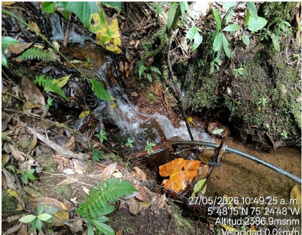
Punto de captación
