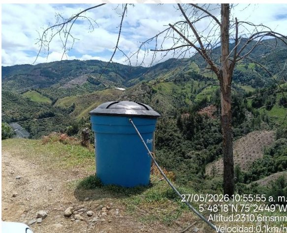
Tanque de almacenamiento
