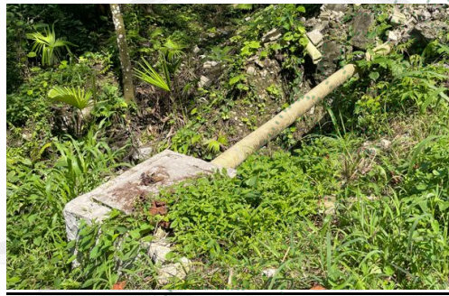
Cámara de cribado implementada.
