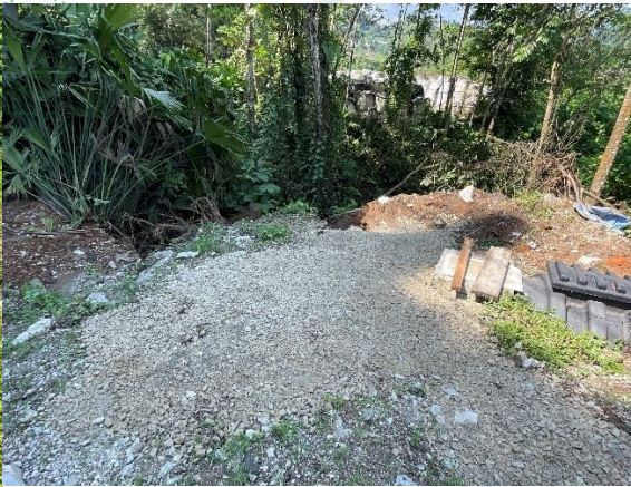
Figura 7. Área dispuesta para el campo de infiltración.
