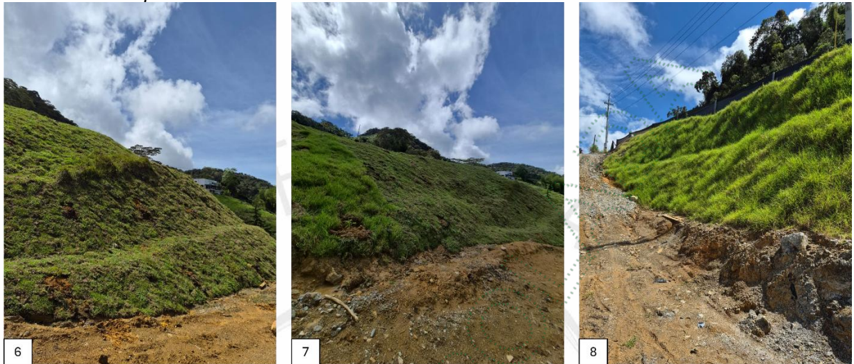
Imagen 6, 7 y 8: Taludes Revegetalizados con pasto Vetiver.
