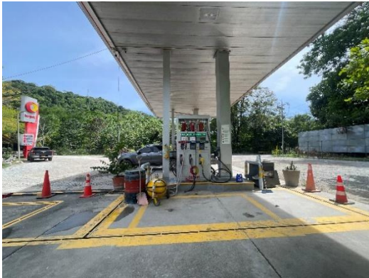
Imagen 1. Cárcamo perimetral de la EDS Río Claro
