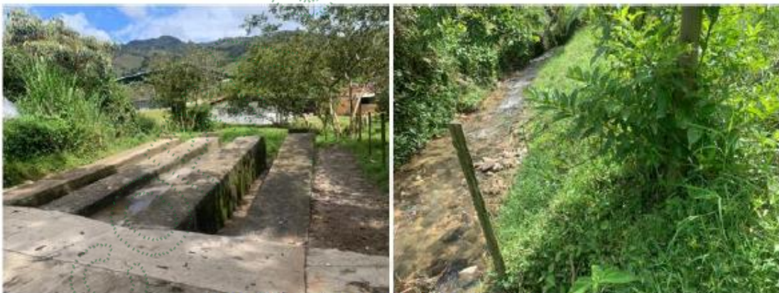
Figura 1. Lavadero de vehículos y fuente de agua
