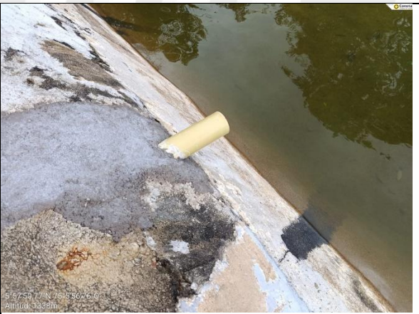
Imagen 6. Descarga aguas lluvia. Cornare 2025
