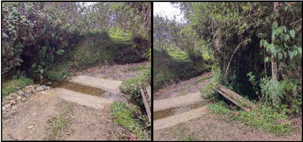
Imagen 2. Cornare. 2025. Batea sobre el cauce de la fuente hídrica aguas arriba del lote de la señora Astrid Maryory Osorio.
