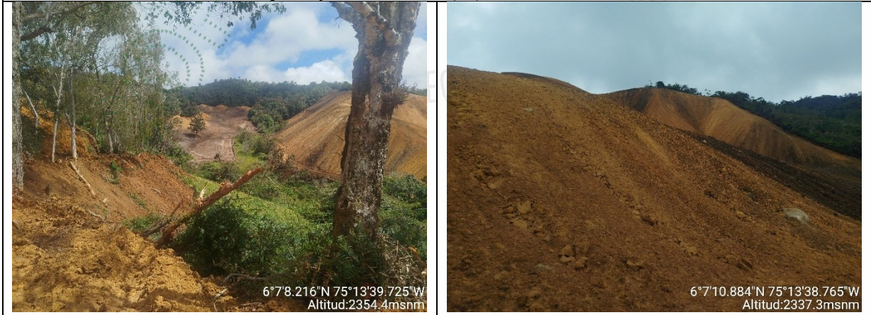
Figura 5 y 6. Actividades de preparación del terreno.
