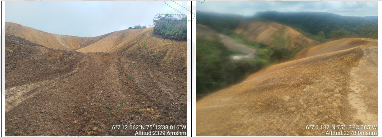
Figura 3 y 4. Actividades de preparación del terreno.
