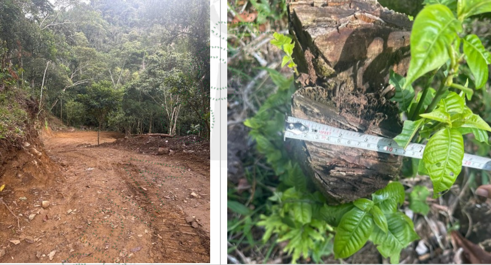
Figura 1. Movimiento de tierra para ampliación de vía y diámetro promedio de árboles talados.
