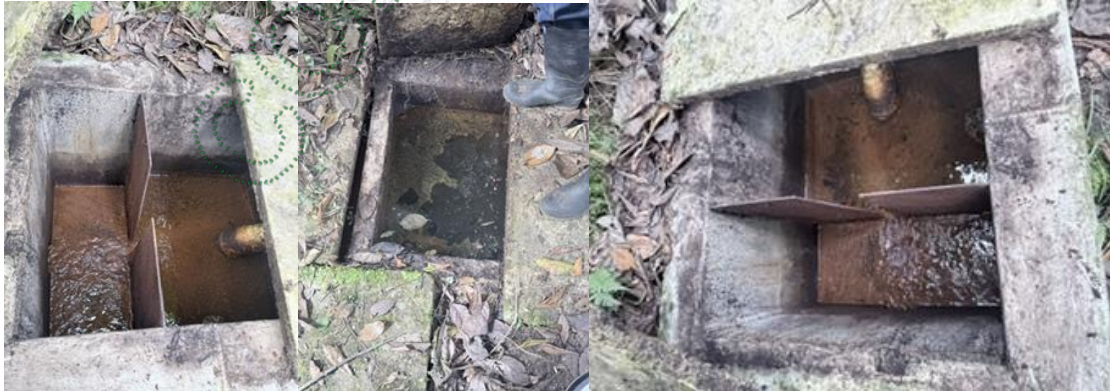
Imagen 5. Obra de derivación
