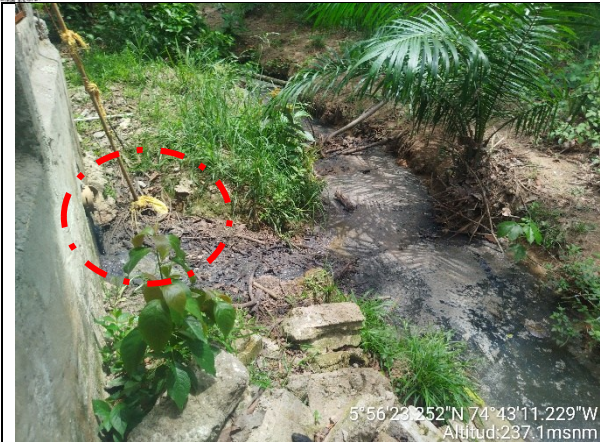
Figura 14. Punto de vertimiento de los corrales en mampostería.
