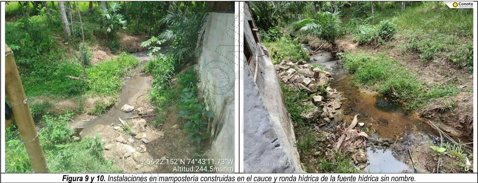
Figura 9 y 10. Instalaciones en mampostería construidas en el cauce y ronda hídrica de la fuente hídrica sin nombre.
