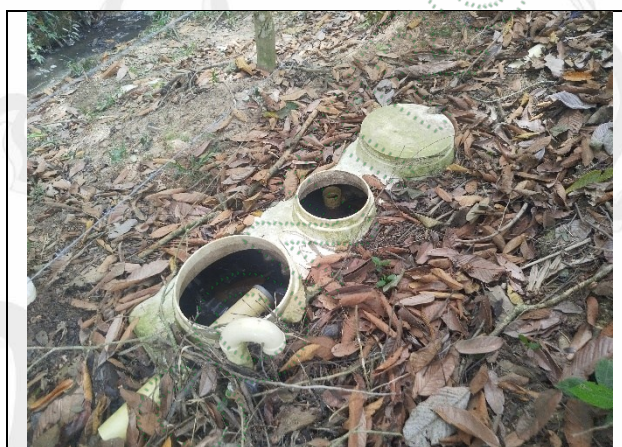
Figura 20. Tanque séptico instalado en el sitio.
