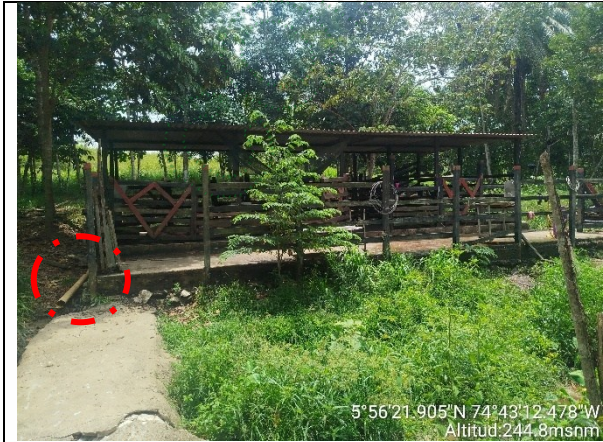
Figura 12. Punto de descarga del cárcamo perimetral y tubería del establo.
