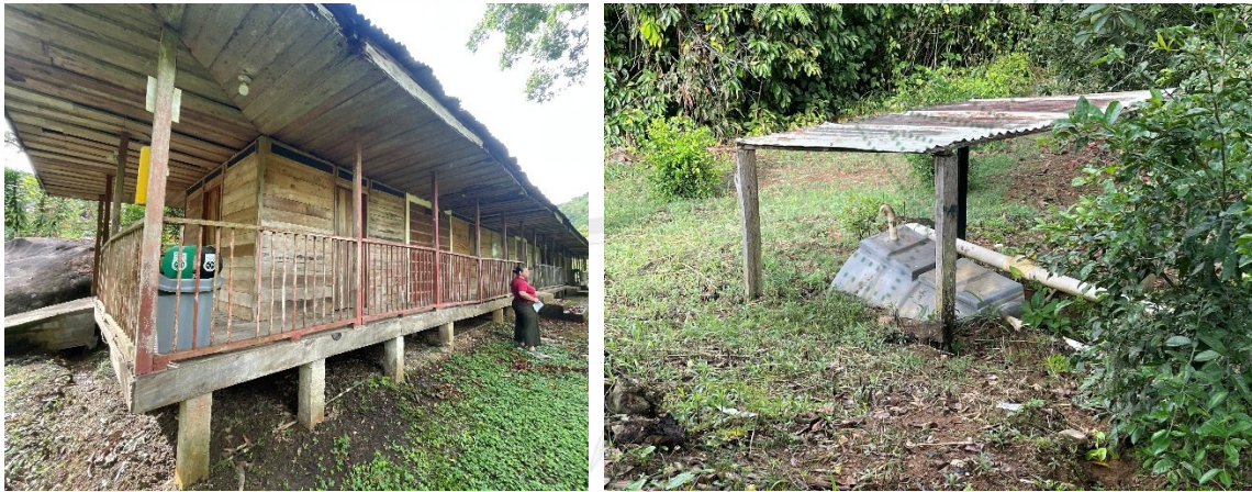
Imagen 3. Cabaña y sistema séptico del predio con FMI: 018-162639, el cual hace parte del Restaurante Los Aragones. Fuente Cornare 2026
