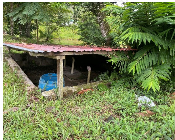
Imagen 2. Sistema de tratamiento implementado para manejar las aguas residuales domésticas del Restaurante Los Aragones. Fuente: Cornare 2026
