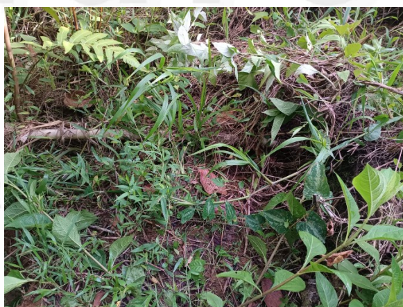
Figura 6. Tubería saliente del sistema
