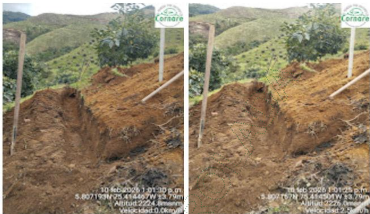
Zanja de infiltración
