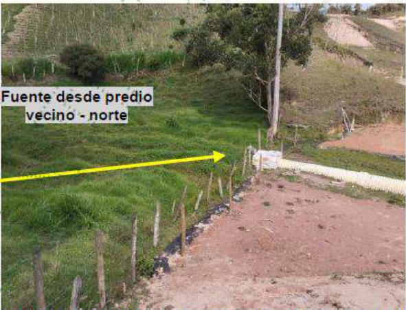
Figura 10. Contención de fuente del lindero norte en tubería y muro en costales
