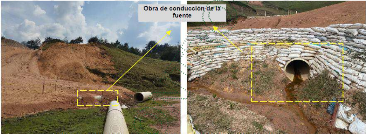
Figura 8. Conformación de llenó sobre fuente hídrica y encausamiento de dos flujos de agua
