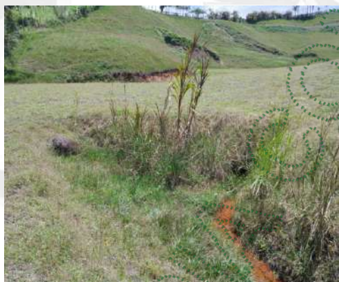
Figura 4. Lleno sobre tuberías de conducción de las fuentes hídricas y conducción sobre canal conformado.
