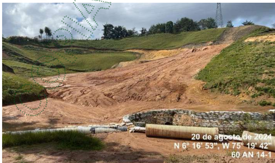
Figura 10. Localización de tuberías, lleno estructural y muro en costales sobre ronda hídrica.
