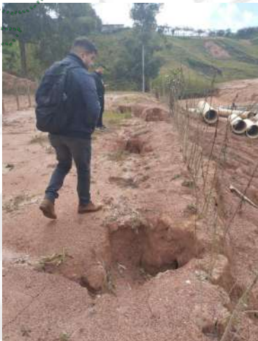
Figuras 5 y 6. Procesos erosivos en taludes del costado noroccidental del predio
