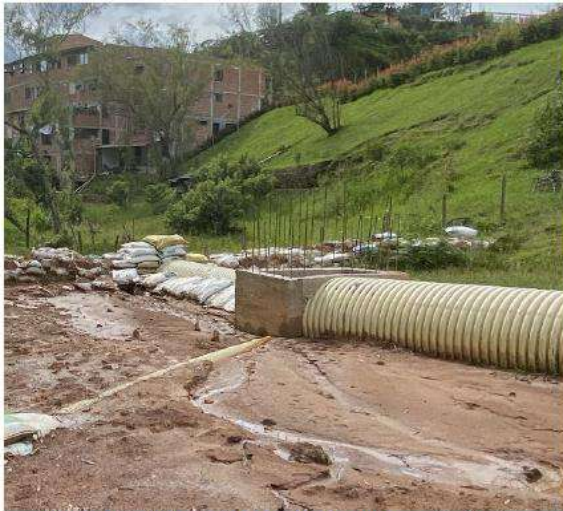
Figura 18. Caja de inspección de zona central baja.
