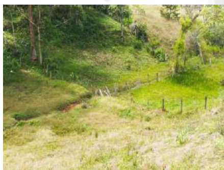
Figura 8. Muro en costales sobre lindero sur del predio y en ronda hídrica.
