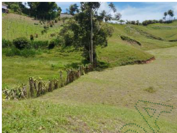
Figura 7. Continuación de lleno y tuberías sobre la fuente hídrica del costado occidental del predio. Se evidencia que persiste el aumento en la cota y la tubería de conducción.
