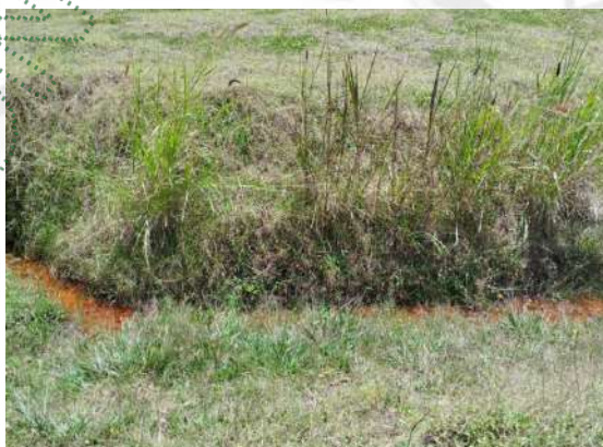
Figura 5. Conducción de las fuentes hídricas por un canal antrópico posterior a las tuberías y el lleno localizado sobre la zona de protección.
