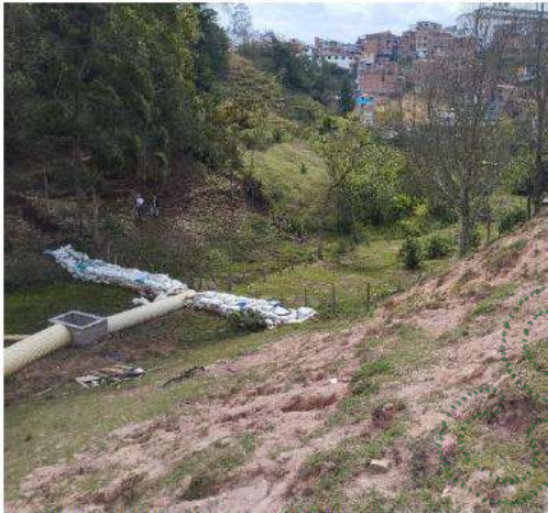
Figura 15. Interrupción del flujo aguas abajo con tubería y muro en costales
