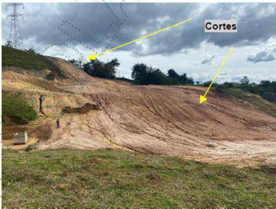
Figura 5. Cortes de talud en costado oriental del predio
