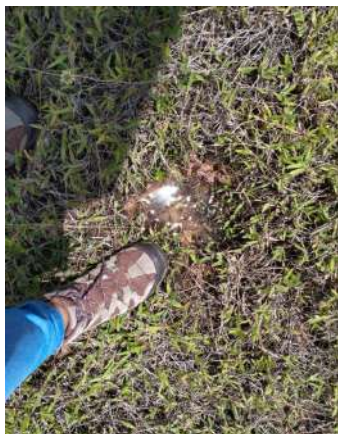
Figura 6. Humedad sobre la superficie del lleno.
