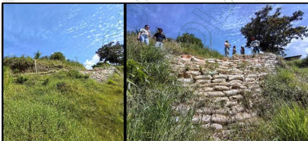
Imagen 3. Cornare. 2026. Estabilización de talud de la vía de acceso a los lotes 3 y 4 (derrumbe 1).
