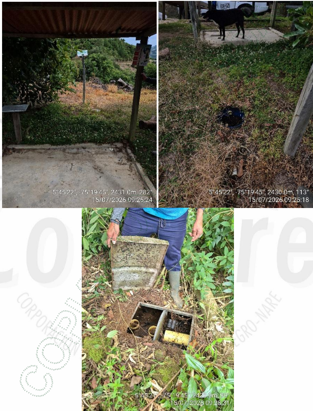
Imagen 2. Izquierda. Zona de preparación de agroquímicos. Centro. Filtro de las aguas residuales no domesticas vertiendo al suelo. Derecha. Sistema de tratamiento de aguas residuales domésticas.
