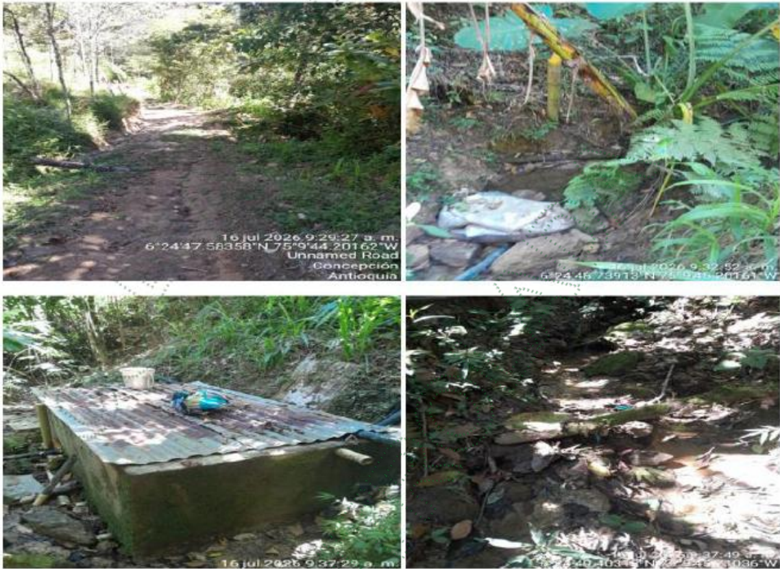
Figura 4. Otras imágenes de la visita realizada, correspondientes a la obra de captación de la escuela, tanque desarenador y de almacenamiento, y camino veredal sobre el cual se instaló la tubería.
