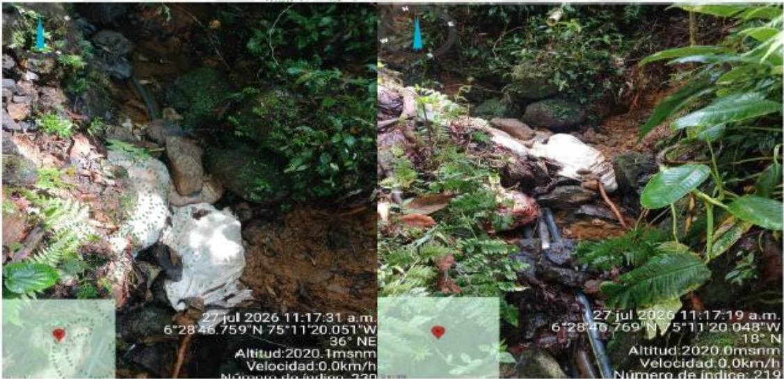
Imagen 2 y 3 obra de captación en la fuente de agua
